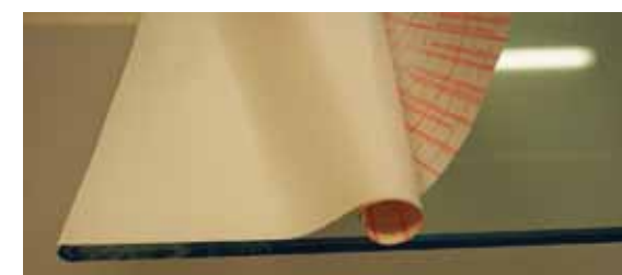
4 — Apliciranje sigurnosne samoljepljive folije na jednoslojne staklene police
