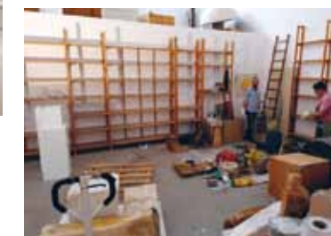
5 — Konstrukcijski radovi u Atelijeru
