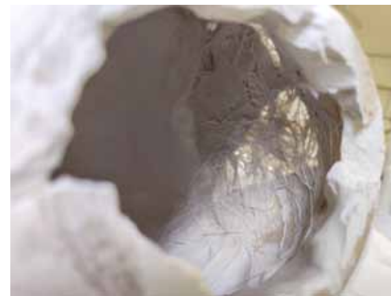
4 — Postavljanje armature od kudjelje
