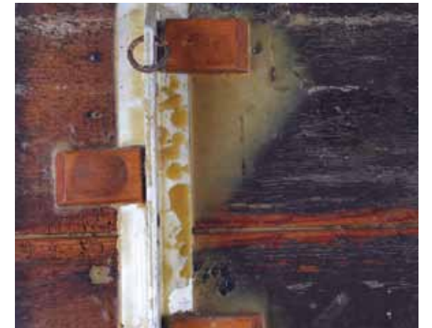
2 — Zatečeno stanje poleđine: detalj, parketaža izvedena 1964.-65.
